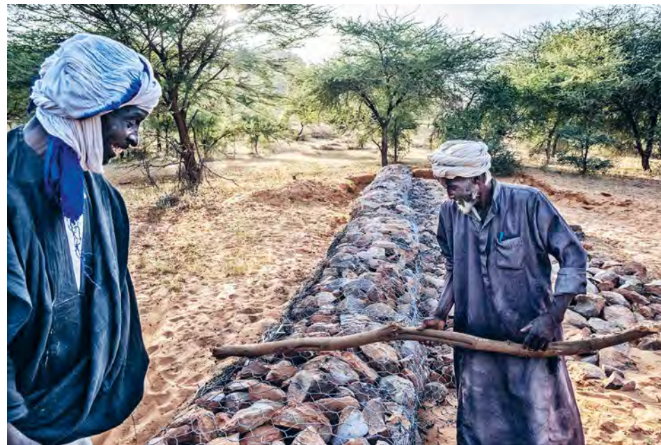
Deux membres d'un comité de gestion local constatent le bon fonctionnement des seuils de ralentissement pour combattre l'érosion. Oudey Ejride, Assaba. © Tim Dirven / VSF
